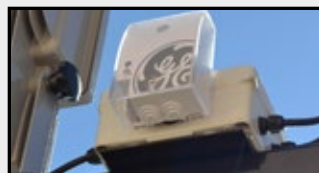
Crepuscular relay (light sensor). Relé crepuscular (sensor detector de luz). Lys sensor. Relais crepusculaire ( détecte la lumière du jour )
